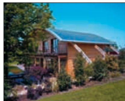
Bild 15: Gerundetes PV-Dach, RZ
