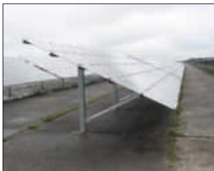
Bei dieser 40 MW-Anlage in der Nähe von Leipzig wurde das Fundament gerammt und ein Montagesystem von Schletter eingesetzt.
