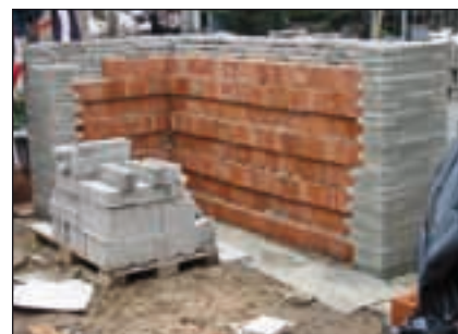
Bild 2: Die Innenwände bestehen aus Ziegelmauerwerk, ebenso der Kern der Außenwände.
