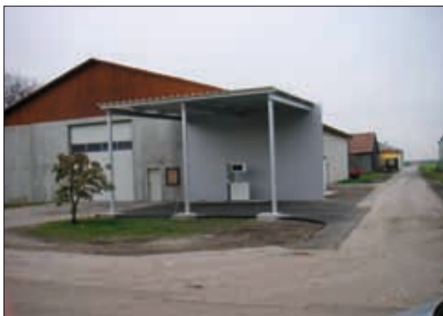
Biogastankstelle in Österreich
