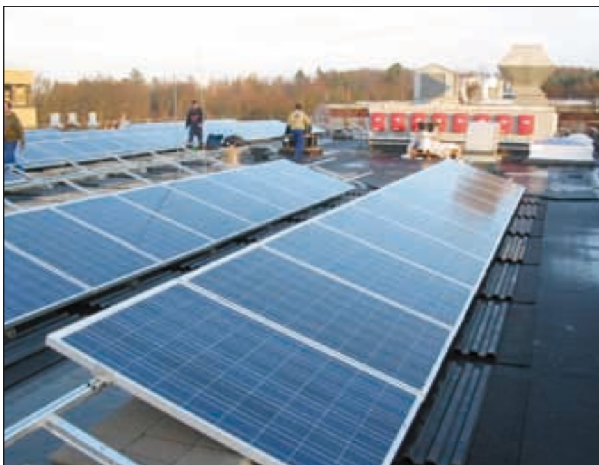
Montagearbeiten bei einer großen PV-Anlage
