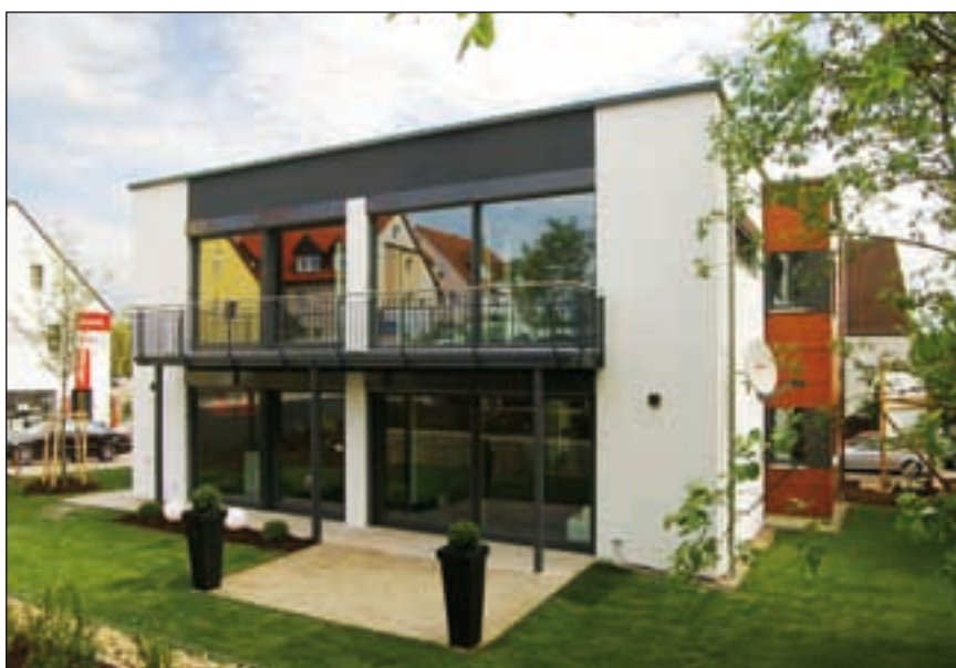
Die Neumarkter Firma Fischerhaus eröffnete im Fürther Sonnenbezirk Vach nach eigener Aussage „ein Passiv-Musterhaus höchster Qualität“
