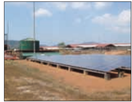
Bild 2: Hybrid 50 kWp PV und B35 kWel Biogas System, Provinz Sihanoukville
