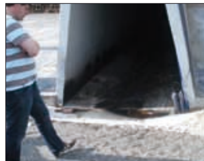
Bild 2: Das Vorbild: Silosickersaft wird am Fahrsilo erfasst und in der BGA mit vergoren
