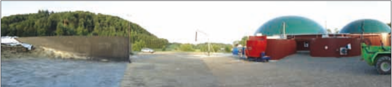
Bild 1: Biogasanlage auf höchstem Niveau: Einsatz von Rinderfestmist, Gülle, Landschaftspflegegras, Gras und geringstem Anteil von Silomais
