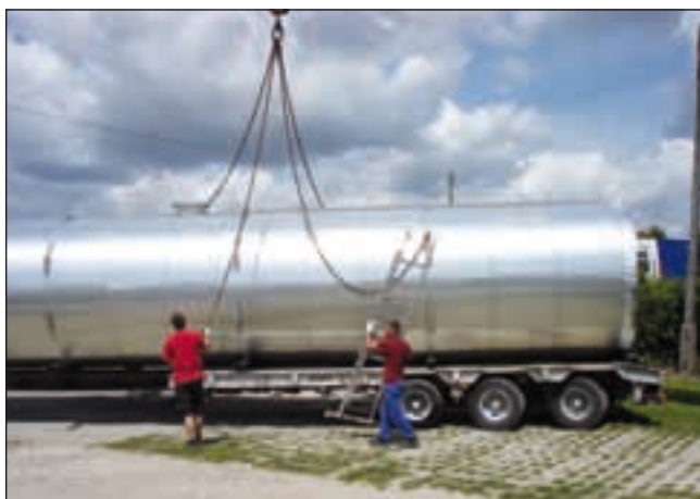
Bild 2: Anlieferung und Montage des Gärbehälters
