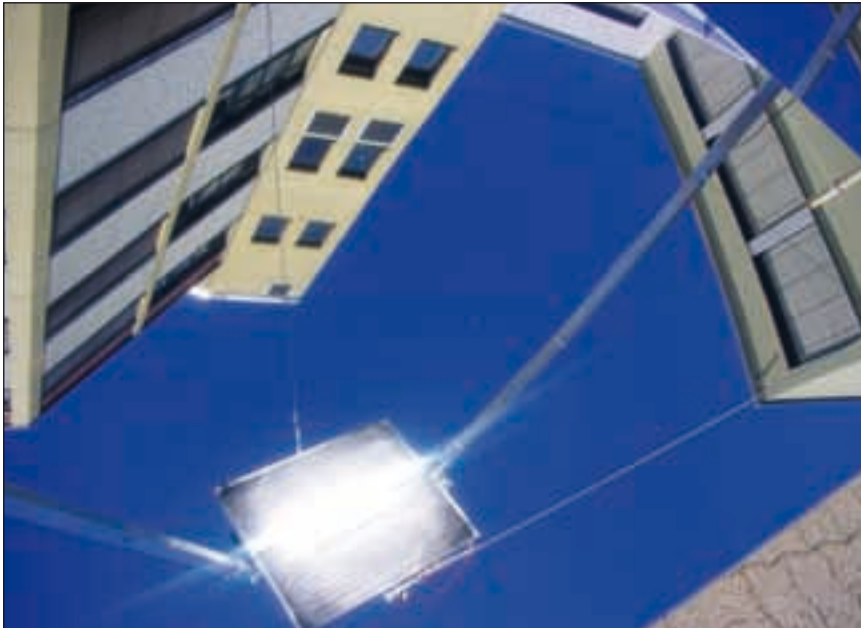
Bild 1: Blick in einen Aluspiegel, der auf den Wärmetauscher ausgerichtet ist.
