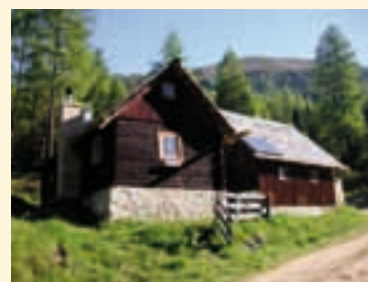
Privat z.B. das Inselstromnetz einer Almhütte
