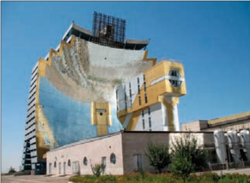
Bild 1: Solarofen 1 MW, Parkent, Usbekistan
