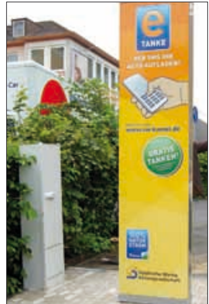
Bild 3: In diesem Jahr wirbt die Kasseler Städtische Werke AG an der wieder eröffneten Solartankstelle für „GRATIS TANKEN“
