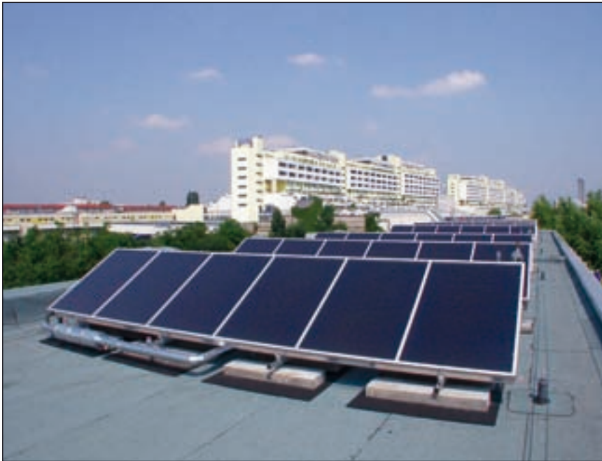
Bild 1: Die Randbebauung des Komplexes Schlangenbader Strasse in Berlin-Schmargendorf wurde 2006 solar modernisiert
