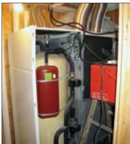
Bild 1: Kompakt-Luft-Wärmepumpe: links: Wärmepumpe und Wärmerückgewinnung aus der Abluft rechts: Geöffneter linker Teil der Wärmepumpe mit dem 200 l Warmwasserspeicher
