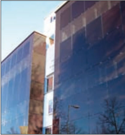
Saniertes Gebäude der Baufirma Jako in München mit PV-Fassade
