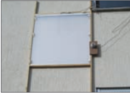
Bild 1: Mit Nanogel gefüllte Stegdoppelplatte an der Südfassade
