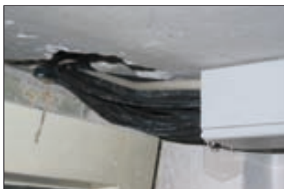
Bild 2: Auch eine gute Kabelverlegung will geplant sein.
