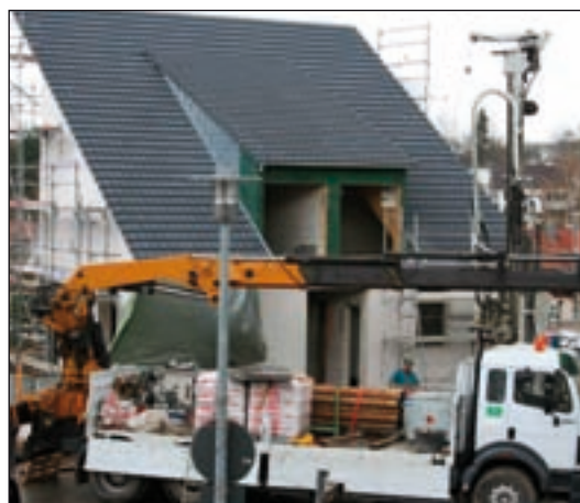
Bild 2: Einrichtung des Bohrgerätes während der Bauphase des Hauses
