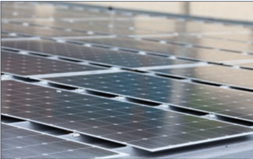
Bild 1: Direktverklebung von rahmenlosen kristallinen Photovoltaikmodulen auf ein Metalltrapezdach mit Sikasil® SG-20
