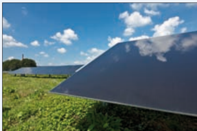
Bild 4: Solarpark in Neustadt bei Coburg, Verklebung von 5,7m 2 großen Glas-Glas Laminaten mit Sikasil® AS-785
