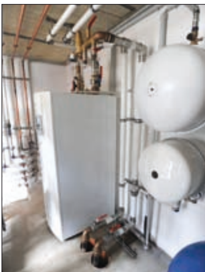
Bild 3: Im Hintergrund die Wärmepumpe Supraeco T520 und vorn die Membranausdehnungsgefäße
