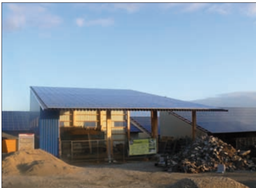
Bild 1: Mit Photovoltaik überdachte Lagerplätze
