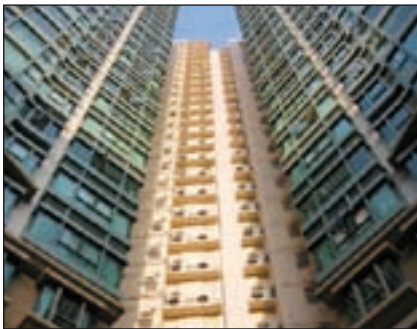
Bild 1: Klimageräte in Hongkong
