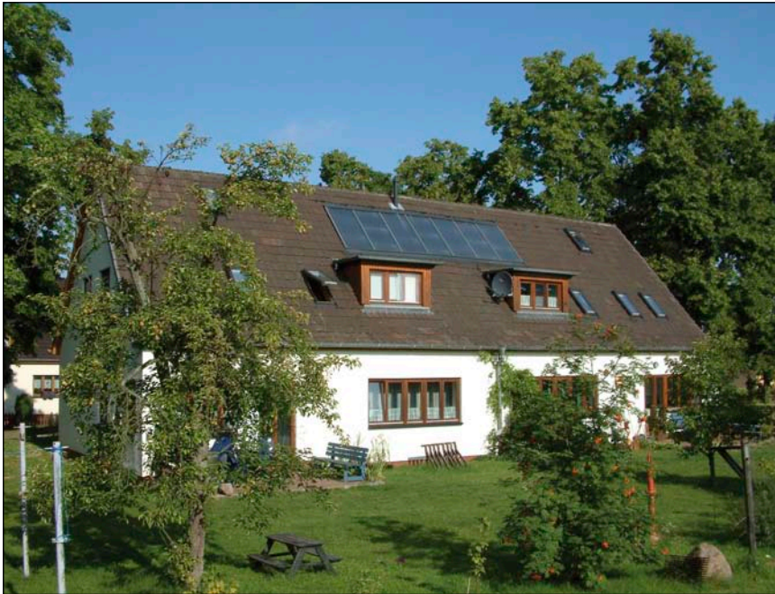
Bild 1: Haus von SO mit 14 m 2 Flachkollektor
