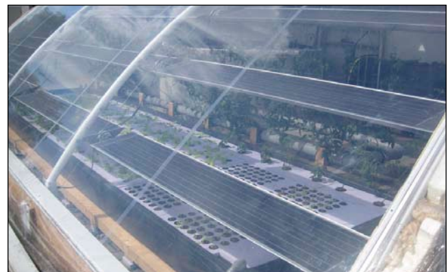
Bild 2: Außenansicht mit keimenden Pflanzen und PV-Lamellen
