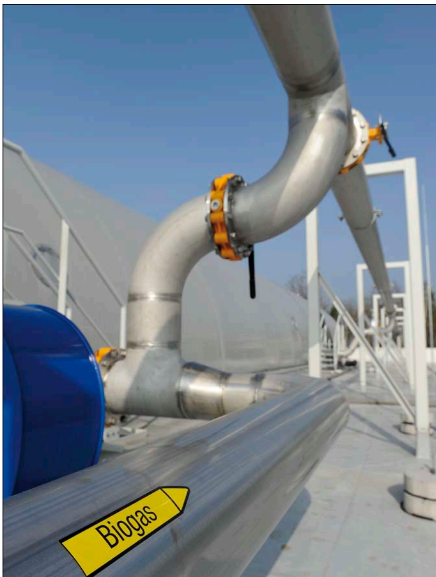
Bild 1: Biogasanlage am Kompostwerk Bützberg der Stadtreinigung Hamburg, aus Bioabfällen wird per Trockenfermentation Biogas und hochwertiger Kompost gewonnen
