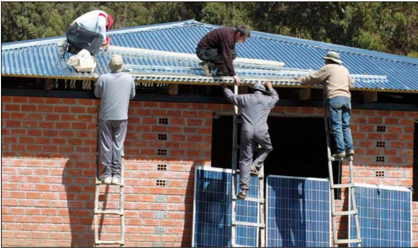
Bild 1: Dr. Matthias Klauß, DGS Thüringen, installiert die Solaranlage für das Gesundheitszentrum gemeinsam mit lokalen Technikern
