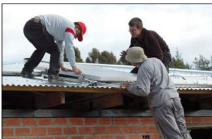
Bild 3: Einweisung in die Installation der Module während des Baus der Anlage
