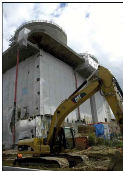
Bild 3: Presslufthammer und Bagger rücken dem Bunker zu Leibe, um ihm eine neue Funktion zu verpassen.
