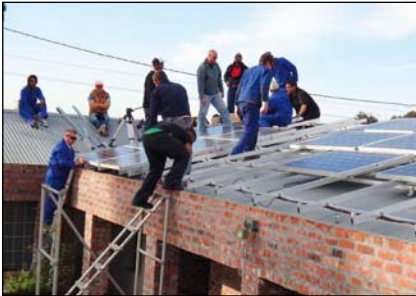
Netzgekoppelte Aufdachanlage in Kapstadt im Bau
