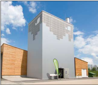
Bild 1: Vergasungskraftwerk mit einem Heatpipe-Reformer im bayerischen Achenal
