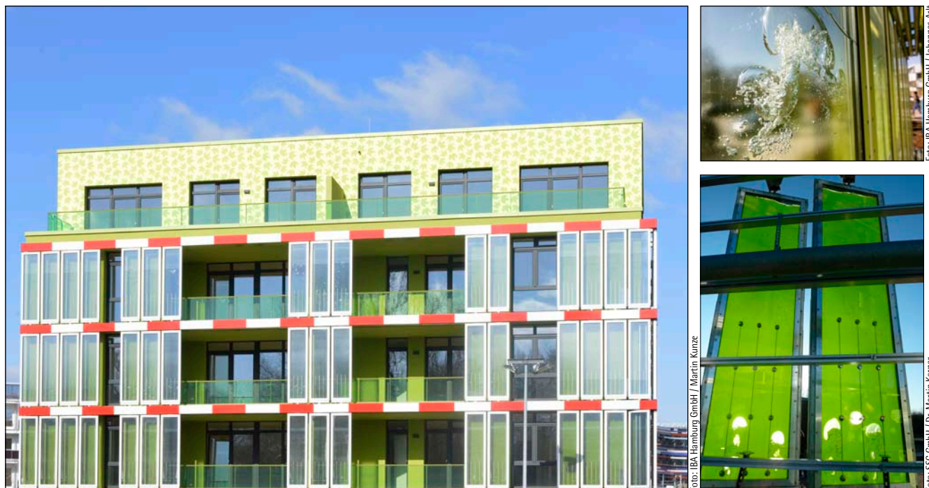
Bild 2: In der Fassade des BIQ sprudelt es schon. Die Luftblasen durchmischen die Algenbrühe, so dass die Algen immer nur kurz an der Oberfläche bleiben. Das Bild unten rechts zeigt den Versuchsreaktor.
