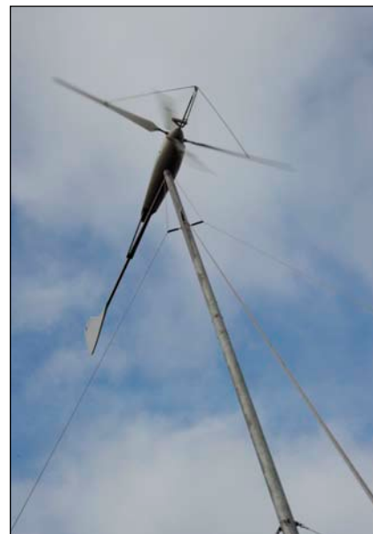
Bild 3: Eine mit Seilen abgestützte 6-KW-Anlage in der Nähe von Flensburg
