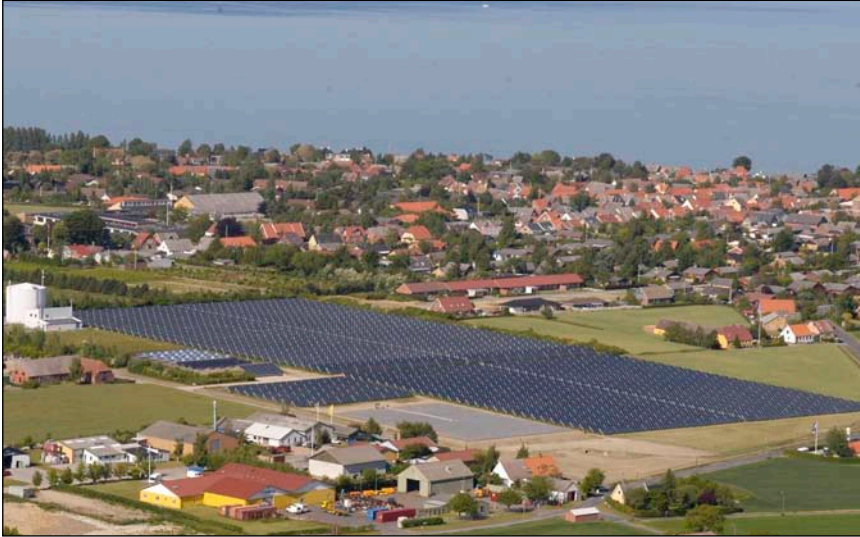
Bild 1: Luftaufnahme der Anlage in Marstal 33.300 m 2 Kollektorfläche, Langzeitspeicher und Heizhaus, in dem ein Blockheizkraftwerk betrieben wird.
