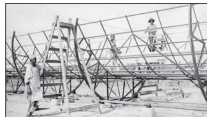
Bild 4: Die Anlage in Maadi wurde von 1912 bis 1913 errichtet. Hier waren die Spiegel noch nicht in die Halterungen eingesetzt
