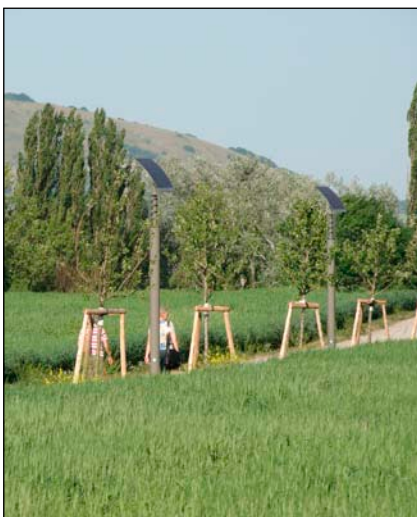
Bild 2: Wegebeleuchtung mit Ecostar Double Sol, Stahlmast und gebogenes laminiertes Solarmodul (links) Nachtansicht der Leuchte mit Lerchenholzmast (mitte) und transparentem Glasmodul (rechts)
