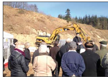
Bild 2: Baubeginn für den Speicher in Dronninglund
