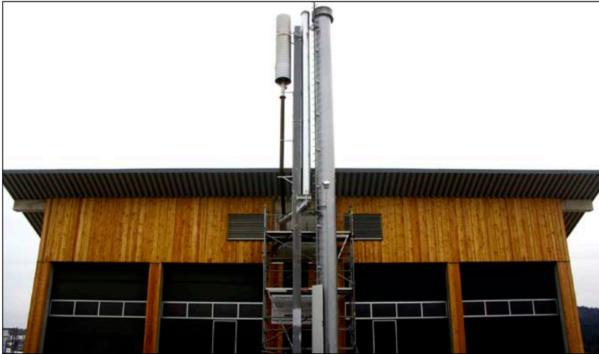
Bild 1: Holz-Heizkraftwerk Wunsiedel-Schönbrunn der SWW Stadtwerke Wunsiedel GmbH seit Januar 2013 offiziell in Betrieb
