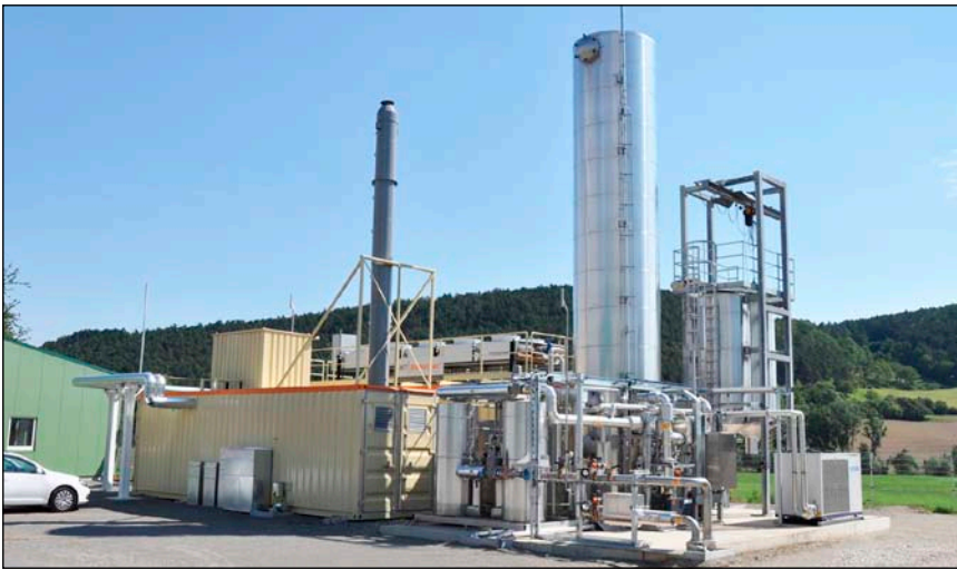
Bild 1: Gasaufbereitungsanlage, die Biogas zu Biomethan „veredelt“
