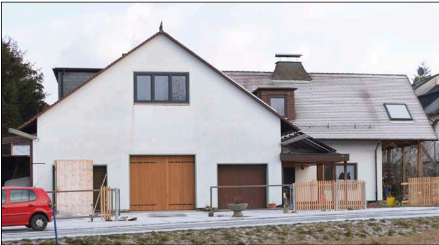
Bild 1: Hausansicht von Westen
