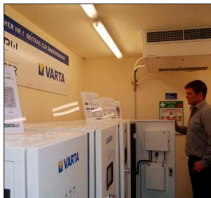
Bild 2: Lithium-Ionen-Schränke von Varta im „Spitzenpeicher Nr. 1“ der ODR-Netzgesellschaft in Neuler-Schwenningen
