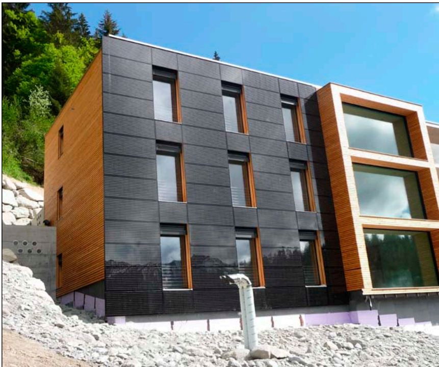
Bild 1: Für das „Ecobauhaus“ im schweizerischen Laax hat der österreichische BIPVLieferant MGT-esys eine komplett geschlossene Fassade aus opaken PV-Elementen geschaffen.
