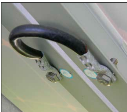
Bild 3: Es ist nicht absolut klar, wann die Erdung von Modul-Rahmen vorgeschrieben oder verzichtbar ist.
