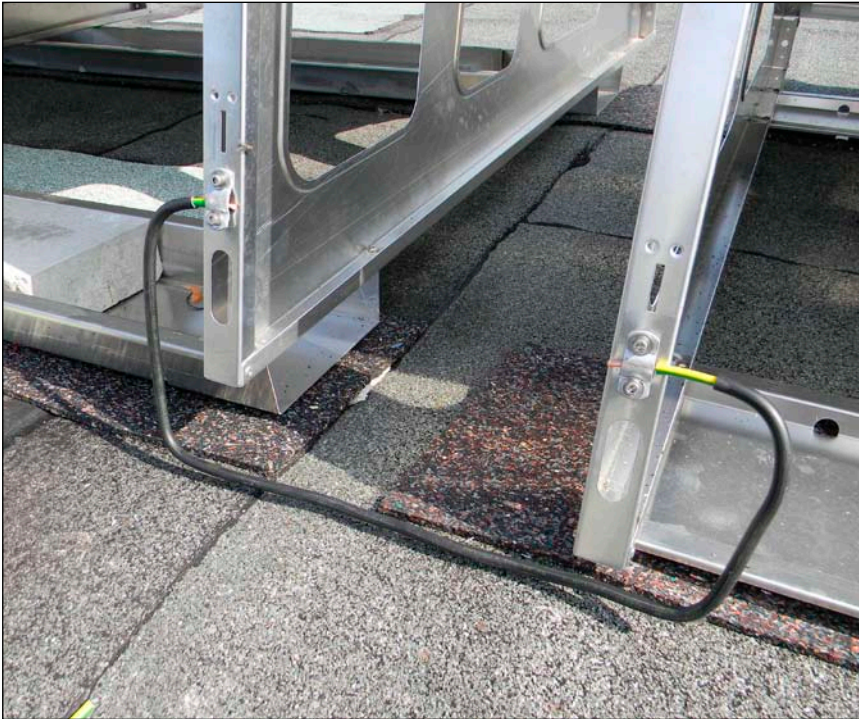
Bild 1: 16 mm 2 Kupfer als konstruktiver örtlicher Potenzialausgleich, Schutzpotentialausgleich und Funktionserdung (Blitzschutz) in einem.
