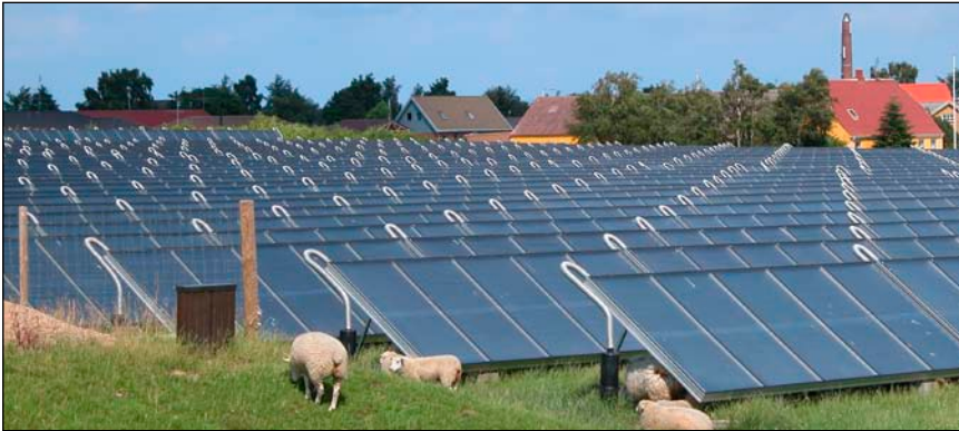
Bild 1: Solarthermie als Freiflächenanlage bei der Marstal Fjernvarme auf der dänischen Insel Aerö. Die Kollektorfläche wurde auf 33.400 m 2 , entsprechend einer Nennleistung von 23,4 MW th , erweitert. Die Kosten betragen rund 175 Euro/m 2 .
