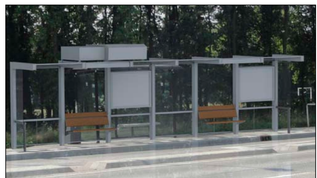
Bild 2: Auf den Wartehallen der Endhaltestellen werden Ladestationen errichtet. Der Anschluss an das Mittelspannungsnetz erfolgt über eine Trafostation in der Nähe der Haltestellen.
