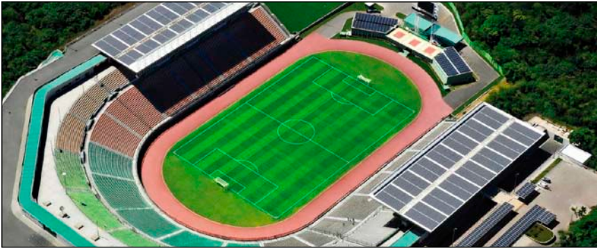
Das erste WM-Stadion mit einer netzgekoppelten PV-Anlage, Pitucaçu in Salvador da Bahia
