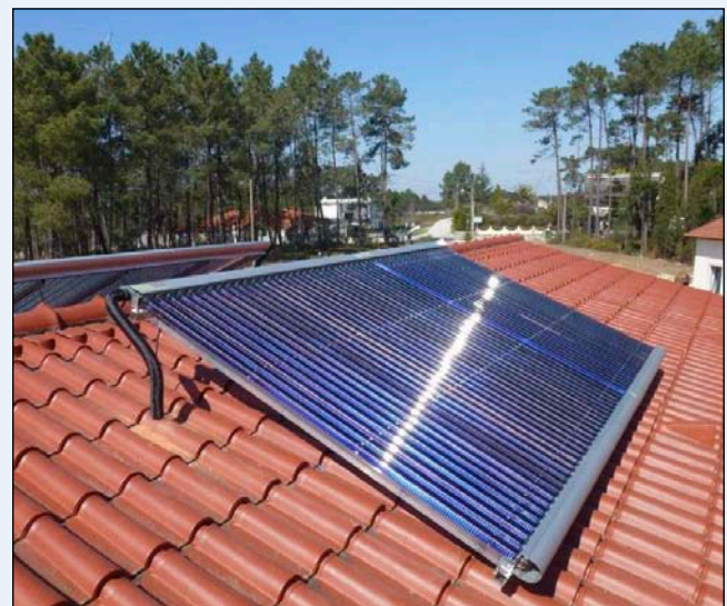
Bild 3: Akotec-Anlage mit eigensicheren Narva Heatpipe-Vakuumröhren in Portugal
