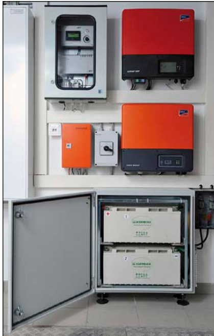
Bild 1: AC-Speichersystem mit Bleiakkus und Backup-Funktion
