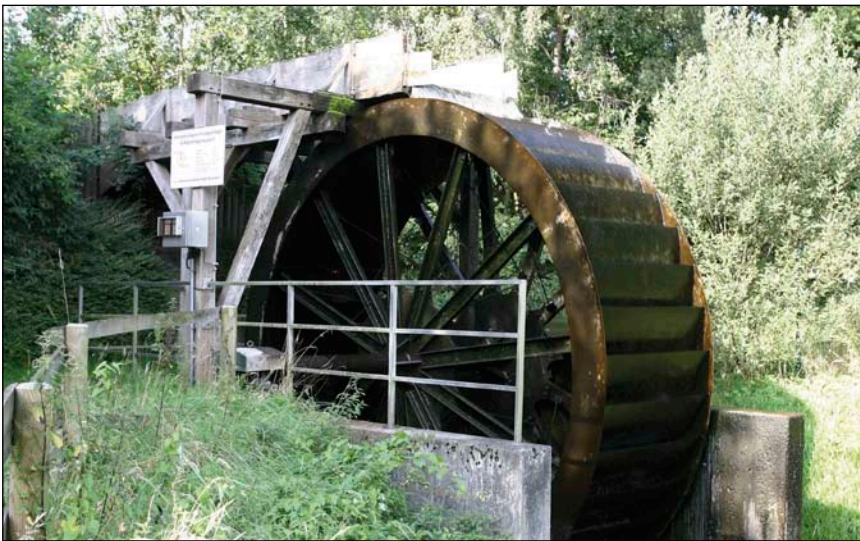
Bild 1: Wasserrad am Auslauf der Kläranlage Warendorf
