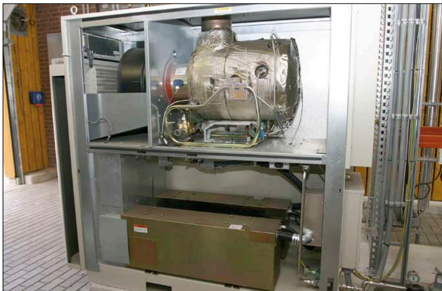
Bild 3: Geöffnete Mikrogesturbine
