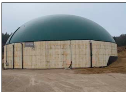
Bild 3: Neue Biogasanlagen werden kaum noch gebaut
