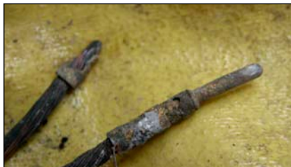
Bild 5: Reste zweier Steckverbinder aus dem Schutt eines Dachstuhlbrandes. Der rechte Stecker ist in Ordnung, beim linken ist der Kontaktstift durch einen Lichtbogen verdampft worden.
